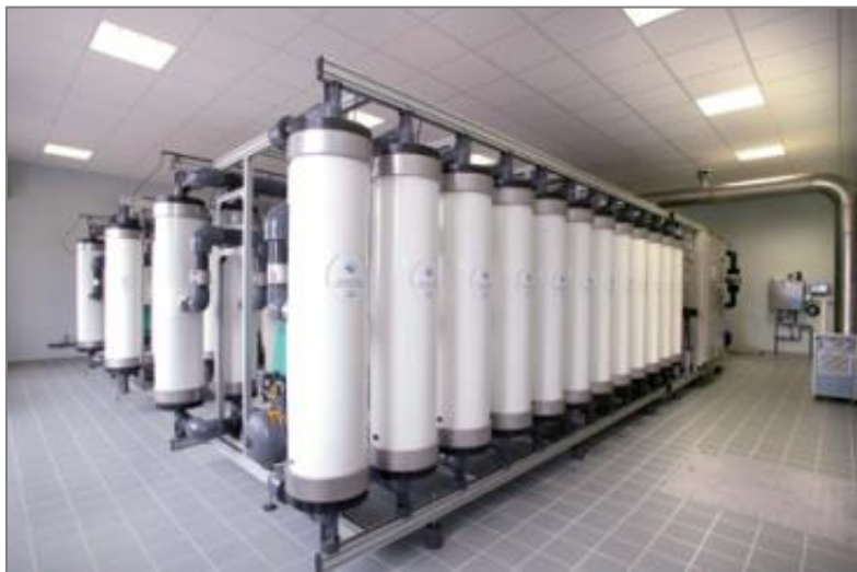
Figure 5.20 Exemple de Skid d'ultrafiltration
